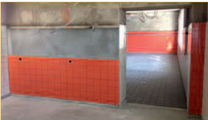
Fliesen im Umkleidebereich
